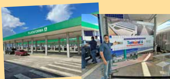
Ordem de Serviço para obras no T6
